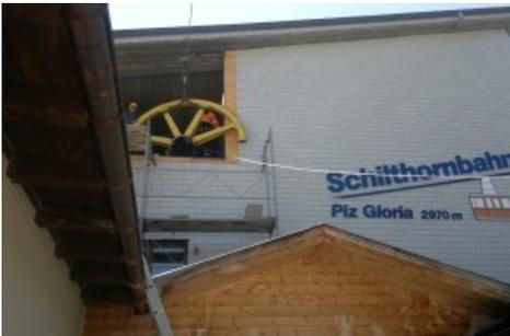
*Schilthornbahn - Schadenbehebung verläuft planmässig. Das defekte Umlenkrad wird aus der Station gehoben. Dazu musste vorgängig die Stationsfassade demontiert werden. / Weiterer Text ueber ots und auf <http://www.presseportal.ch>. Die Verwendung dieses Bildes ist fuer redaktionelle Zwecke honorarfrei. Veröffentlichung unter Quellenangabe: "ots.Bild/Schilthornbahn AG".*
