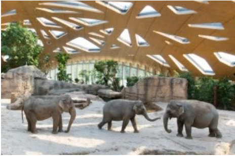
(Bild: Zoo Zürich, Jean-Luc Grossmann) Eine filigrane Betonkonstruktion - mit Sika® ViscoCrete® Fließmittel - stützt das 1'500 Tonnen schwere Holzdach. Weiterer Text über OTS und www.presseportal.ch/pm/100053867 / Die Verwendung dieses Bildes ist für redaktionelle Zwecke honorarfrei. Veröffentlichung bitte unter Quellenangabe: "OTS.Bild/Sika AG"
