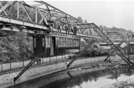
Am 13.09.1898 wurde in der damals selbstständigen Stadt Elberfeld (heute Wuppertal) der erste Prototyp der Schwebbahn ins Gerüst gehängt. Die erste Probefahrt fand im Dezember 1898 statt. Weiterer Text über ots und [www.presseportal.de/nr/128710](http://www.presseportal.de/nr/128710) / Die Verwendung dieses Bildes ist für redaktionelle Zwecke honorarfrei. Veröffentlichung bitte unter Quellenangabe: "obs/WSW Wuppertaler Stadtwerke GmbH"
