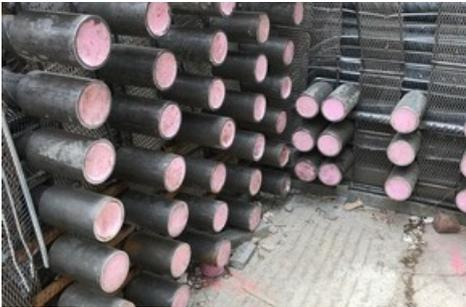
*Da die Bauetappen nicht mit konventionellen Übergreifungsstössen erstellt werden konnten, entschieden sich die Projektverantwortlichen für eine Lösung mit BARTEC® Schraubverbindungen. Weiterer Text über ots und [www.presseportal.ch/de/nr/100053189](http://www.presseportal.ch/de/nr/100053189) / Die Verwendung dieses Bildes ist für redaktionelle Zwecke honorarfrei. Veröffentlichung bitte unter Quellenangabe: "obs/Debrunner Acifer AG/zvg"*
