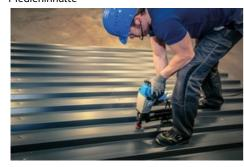
Kein Vorbohren, kein Schrauben: die BECK RoofLoc $^{\circledcirc}$  SCRAIL $^{\circledcirc}$  wird per Druckluft eingeschossen
