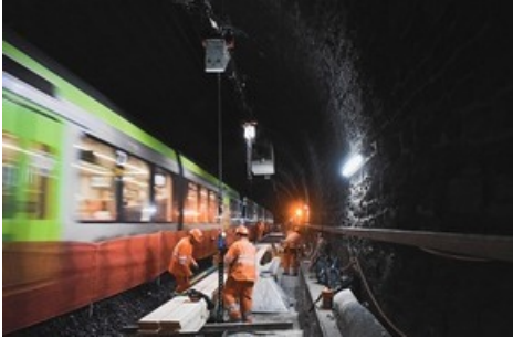
Marti Tunnel AG, ARGE Marti Loetschberg Scheiteltunnel, Monorail, Gleiseinbau, Schotter
