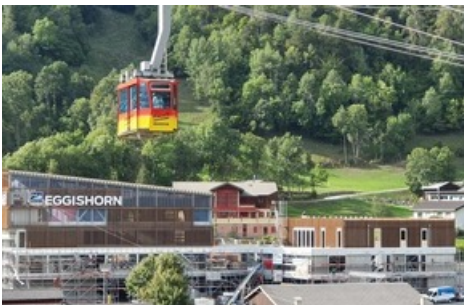
Alt und Neu: Die alte Luftseilbahn Fiesch - Fiescheralp "fliegt" über den neuen ÖV-Hub in Fiesch. Die alte Luftseilbahn wird im Frühling 2020 zurückgebaut. □ 18.9.2019 - Aletsch Bahnen - Martin Röthlisberger
