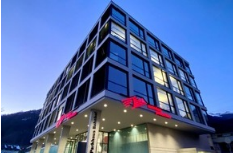
Verwaltungsgebäude von MGBahn und GGB in Brig (VS)
