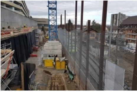
Bauarbeiten am Bahnhof Wabern (Bild: BLS).
