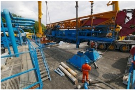
Tiefbohrung TBO Boezberg 2, Nagra, Bohrstelle, Geologisches Standortgebiet Jura Ost; Boezberg, AG, Nagra Tiefbohrung, Bohrstelle, BOZ 2
