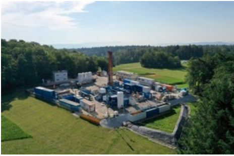
Der Bohrplatz Bözberg-2 im Gebiet Riedacker.
