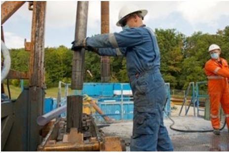
Entnahme eines Bohrkerns bei der Tiefbohrung in Bözberg (Gebiet Riedacker).
