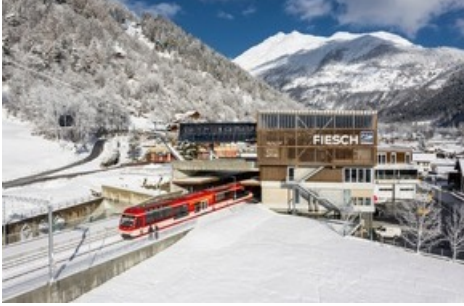
Der neue ÖV-Hub in Fiesch Bus, Bergbahn und Postauto barrierefrei vereint (c)aletscharena.ch - pascal gertschen
