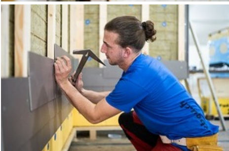
Millimeterarbeit. Jannick Streule verkleidet die Fassade mit Eternit. @SwissSkills
