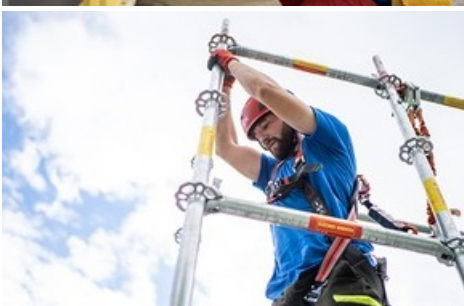
In luftiger Höhe. Robin Furrer im Gerüstbau-Wettbewerb. @SwissSkills
