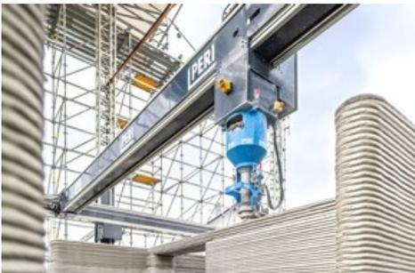
*PERI 3D-Betondruck: Der Druckkopf bewegt sich über drei Achsen und kann sich in seinem Rahmen an jede Position innerhalb der Konstruktion bewegen. / Weiterer Text über ots und [www.presseportal.de/nr/148449](http://www.presseportal.de/nr/148449) / Die Verwendung dieses Bildes ist für redaktionelle Zwecke honorarfrei. Veröffentlichung bitte unter Quellenangabe: "obs/PERI GmbH"*
