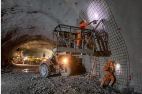
Während den Bauarbeiten (Bild: S. Irgartinger/BLS).
