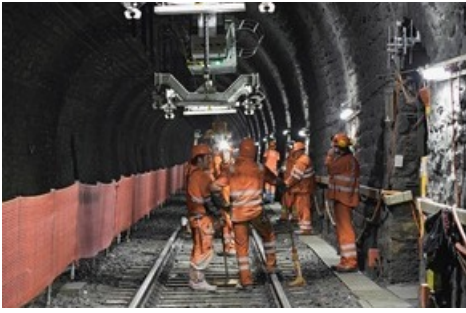
Bauarbeiten im Lötschberg-Scheiteltunnel
