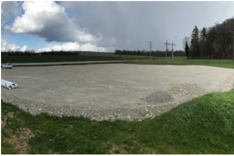
Der geplante Bohrplatz in Rheinau. Am Montag fahren hier die Baumaschinen auf.
