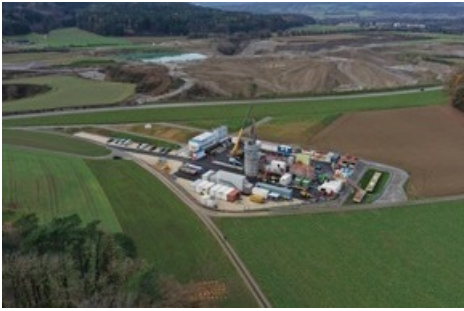
Der Nagra-Bohrplatz im Hasliboden in Stadel.
