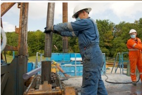
Tiefbohrung TBO Boezberg 2, Nagra, Bohrstelle, Bohrgeraet, Geologisches Standortgebiet Jura Ost; Boezberg, AG, Nagra Tiefbohrung, Bohrstelle, BOZ 2
