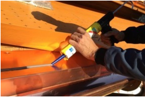
Anschluss von Ampatop Seal (TPU) auf das Traufblech.
