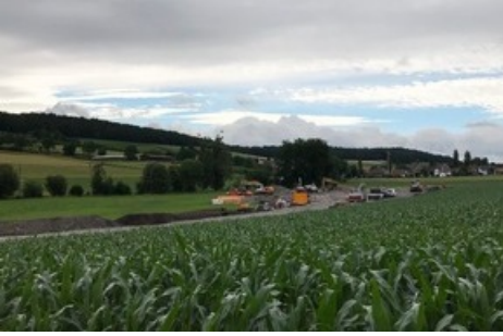
Der Bohrplatz in Bachs wird vorbereitet.
