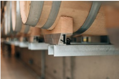
Jeder Stahlträger ist mit Sensor-Technologie bestückt
