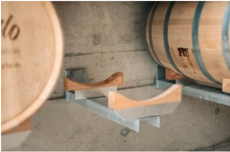
Neuheit: Jedes der 450 Fässer lagert auf einem Stahlträger, der mit Sensoren bestückt ist.
