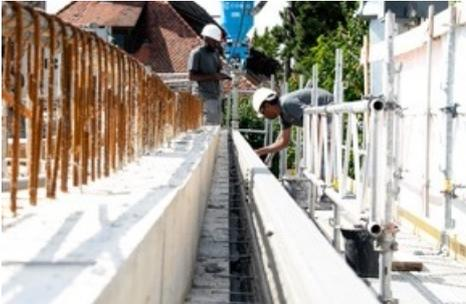
*PERI realisiert weltweit erste Wohnhausaufstockung mit der 3D-Betondruck-Technologie in Lindau/Bodensee / Weiterer Text über ots und [www.presseportal.de/nr/148449](http://www.presseportal.de/nr/148449) / Die Verwendung dieses Bildes ist für redaktionelle Zwecke unter Beachtung ggf. genannter Nutzungsbedingungen honorarfrei. Veröffentlichung bitte mit Bildrechte-Hinweis.*
