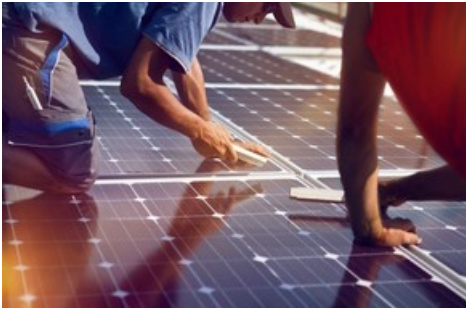
Pose de panneaux solaires sur le toit d'un bâtiment de Sion.
