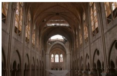
*Bildunterschrift: Mit dem Kreuzrippengewölbe ermöglichten die gotischen Baumeister Räume von nie dagewesener Höhe und Offenheit, indem sie tragende Mauern durch Säulen ersetzen. / Weiterer Text über ots und [www.presseportal.de/nr/13399](http://www.presseportal.de/nr/13399) / Die Verwendung dieses Bildes ist für redaktionelle Zwecke unter Beachtung ggf. genannter Nutzungsbedingungen honorarfrei. Veröffentlichung bitte mit Bildrechte-Hinweis.*
