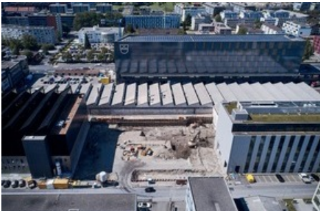
Drohnenaufnahme der Baustelle. Copyright: Tech Cluster Zug.
