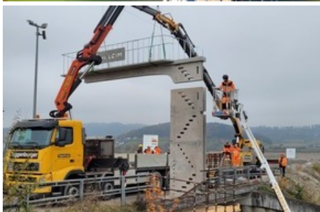
Die vorgefertigten Elemente werden vor Ort zusammengefügt. Quelle: ZHAW.
