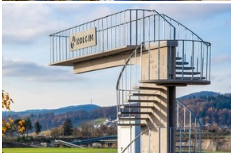
Die filigrane und zugleich funktionale Plattform für die Entgegennahme von Aushubmaterial steht im Holcim Werk Hüntwangen. Das Bauwerk gehört dank einer massiven Materialeinsparung und maximaler CO 2 -Reduktion zu den klimafreundlichsten bewehrten Betonbauwerken weltweit.
