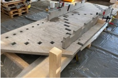
Die einzelnen Platten werden zusammengefügt und mit einem Vergussmörtel verbunden. Quelle: ZHAW.
