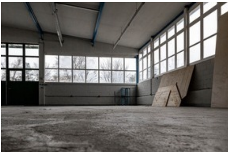
Im the Studios findet man nebst einer industriellen Eventlocation auch verschiedene kleine Werkstätte.
