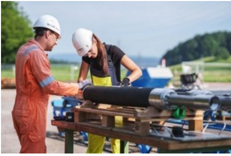
Arbeiten auf dem Bohrplatz.
