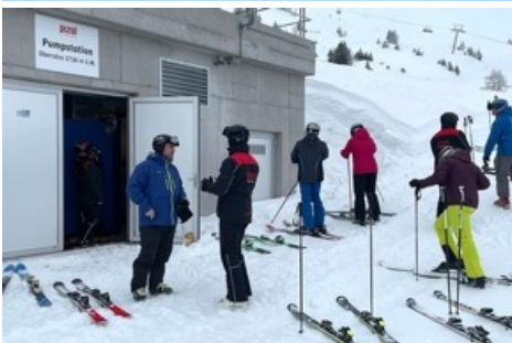
Besichtigung der Pumpstation Obersäss
