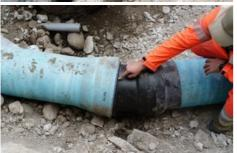
Die Rohre sind aus duktilem Gusseisen, mit Zement ummantelt und verfügen über eine Novo-Sit Verbindung. / Weiterer Text über ots und www.presseportal.ch/de/nr/100053189 / Die Verwendung dieses Bildes ist für redaktionelle Zwecke honorarfrei. Veröffentlichung bitte unter Quellenangabe: "obs/Debrunner Acifer AG/Manuel Lopez"
