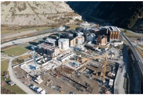
Andermatt Reuss, Baustelle Apartmenthäuser und Infrastruktursockel © Kim Leuenberger
