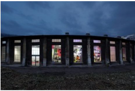
Lokremise St.Gallen, Kunstzone, Nachtansicht
