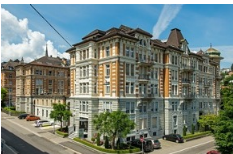
Hauptsitz der SAK (St.Gallisch-Appenzellische Kraftwerke AG) in St.Gallen (Bild: SAK).
