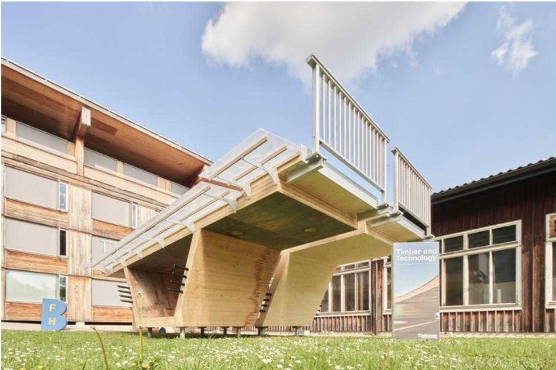
**Der Infrastrukturbau zählt zu den grössten CO<sub>2</sub>-Emittenten der Schweiz. Hauptursache ist der Einsatz von Stahlbeton. Durch den vermehrten Einsatz von Holz könnte der Infrastrukturbau zur Dekarbonisierung beitragen. Schwerlastbrücken mit vorgespannten Hohlkastenelementen würden grosse Bauwerke wie Autobahnbrücken und Viadukte ermöglichen.**
