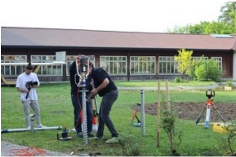
Hier wird das Fundament gebohrt.
