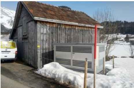
Die Transformatorenstation Chueboden wurde im Rahmen des SAK Netzsanierungsprojekts erneuert (Bild: SAK).
