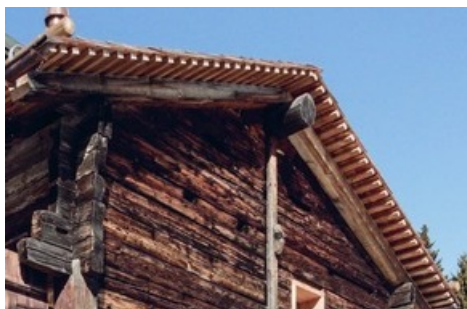
Erneuerte Dachkonstruktion einer Stallscheune, Riederalp Bild: Atelier Summermatter Ritz
