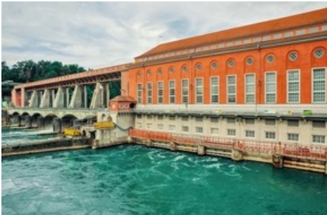
Wasserkraftwerk in Eglisau
