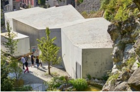
Der neue Sandstein-Pavillon schmiegt sich an den bestehenden Fels im Gletschergarten. © Gletschergarten Luzern
