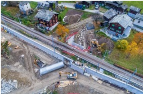
Baustelle Schwiedern (Mattertal)
