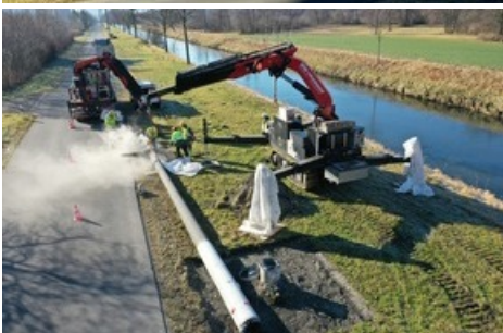
SAK_Ein abgelegter Betonmast wird zersägt, um für den Abtransport bereitgemacht zu werden.
