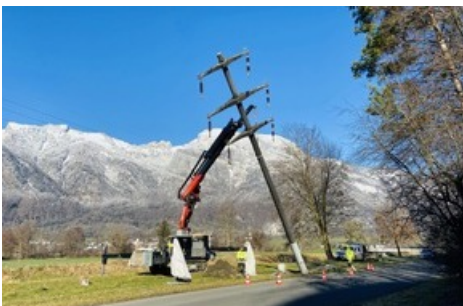
SAK_Rückbau eines 24 Meter hohen Betonmastes
