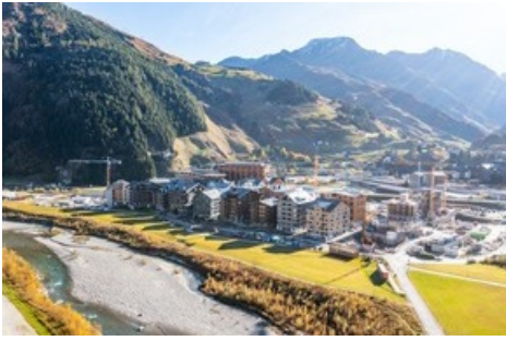
Umweltverträgliche Bautätigkeit in Andermatt Reuss @ Kim Leuenberger
