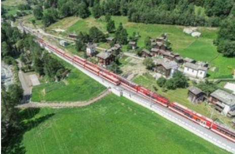
Kreuzung zweier MGBahn-Züge bei der neuen Kreuzungsstelle Schwiedern (VS, Mattertal) nach deren Fertigstellung im Sommer 2018
