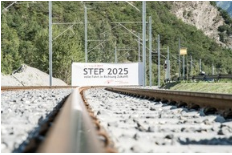
Inbetriebnahme der Kreuzungsstelle Sefinot (VS, Vispताल) im Sommer 2017 - erstes STEP AS 2025-Projekt in der Schweiz
