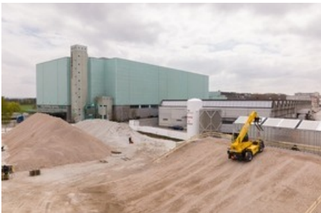
Grossanlage zur CO 2 -Speicherung bestehend aus drei Reihendoseuren.
