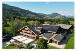
Seit Mai produziert das Hotel Hornberg in Saanenmöser-Gstaad mit dem 1100 Quadratmeter grossen Solarkraftwerk auf seinem Dach täglich mehr als 700 Kilowattstunden Strom. © Hotel Hornberg
