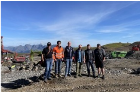
Baustellenbesichtigung IG Sport SG - See Twärchamm / Pizolbahnen AG
