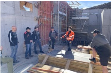
Baustellenbesichtigung IG Sport SG - Pumpenhaus / Pizolbahnen AG
