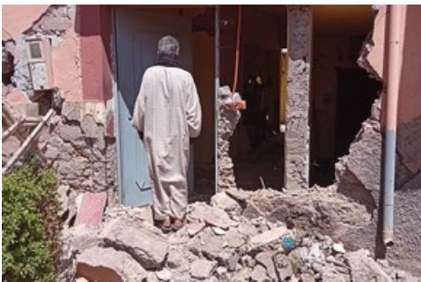
Erdbeben in Marokko - Ein Mann vor seinem zerstörten Haus.
