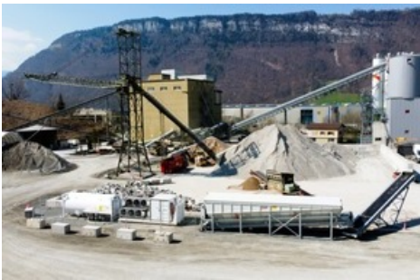
Holcims mobile CO 2 Speicheranlage im Einsatz in Oberdorf, Schweiz
