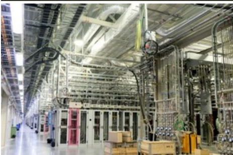
Unter anderem in dieser Halle, die parallel zum 600 Meter langen Beschleuniger verläuft, werden die Systeme der ZHAW eingebaut. Foto: Ulrika Hammarlund/ESS
