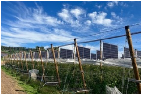
Vertikale PV-Module auf einem Himbeerenfeld (Bild: Bioschmid)
