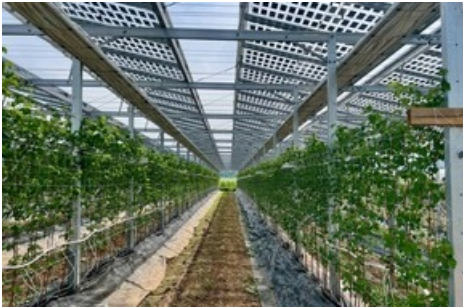
Pilotanlage in Aesch. Himbeeren von Regen, Hagel und Hitze geschützt mit Überkopfverglasung aus Photovoltaikmodulen (Bild: Insolight / Bioschmid)
